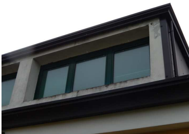
Figura 7 - Particolare discontinuità tra elementi verticali ed orizzontamenti
