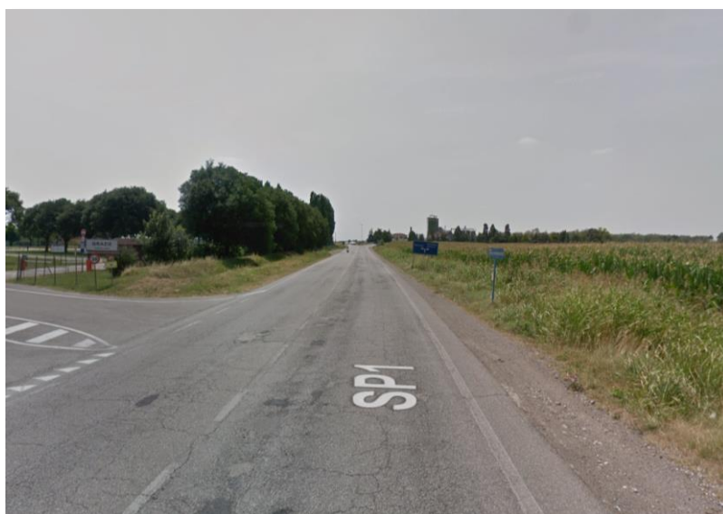
Figura 2-4 Visibilità dell'intersezione sulla S.P. 1
