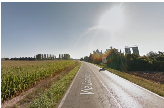
Figura 3-2 Visibilità dell'intersezione sulla ex S.S. 10 – ramo Ovest
