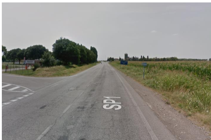
Figura 3-4 Visibilità dell'intersezione sulla S.P. 1
