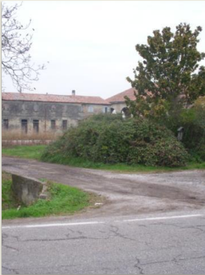
VII.Passo carraio dopo la ferrovia
