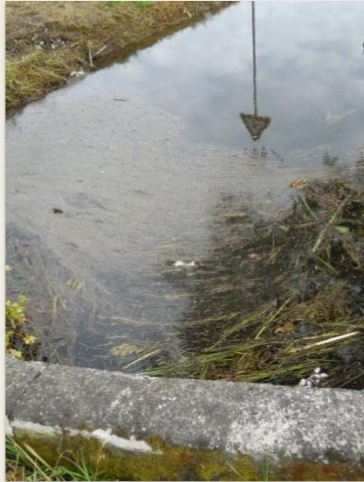
VII.Passo carraio lo stesso dopo le piogge del 20/06/2010
