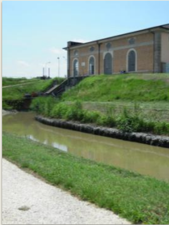
Diversivo Fossaviva, raccoglie le acque provenienti dalla bonifica Fossaviva, confluendo sul lato sinistro dell'impianto.
